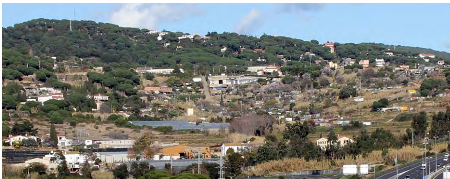
Foto 16 Usos inadequats al Torrent de la Vera
