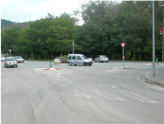
Imatge 10 Senyalització en estat deficient
