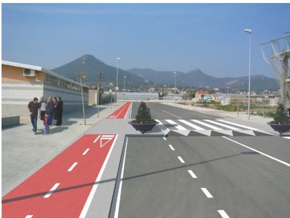
Figura 55 Fotomuntatge proposta d'atri i pas de vianants elevat, amb elements urbans (com per exemple jardineres) que ajuden a la reducció de velocitat.
