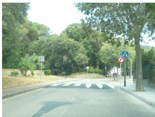
Imatge 20. Carrer de Can Cirés, amb plataforma elevada amb pas de vianants.
