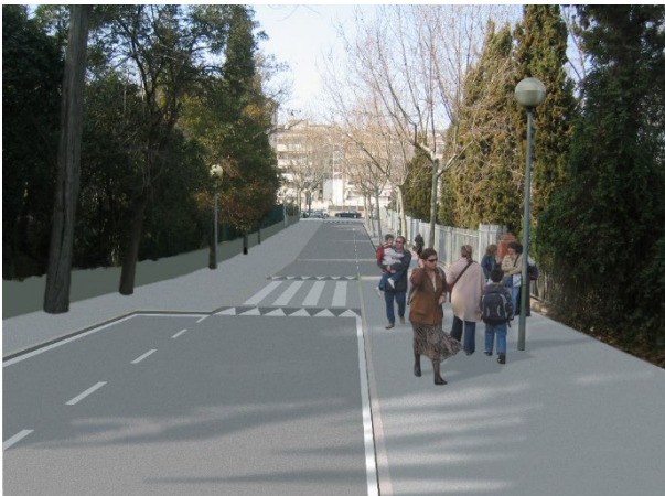
Imatge 19 Carrer amb sentit únic i aparcament alternatiu, que permet l'ampliació de voreres
