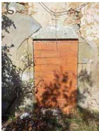
Portal del tercer volum
