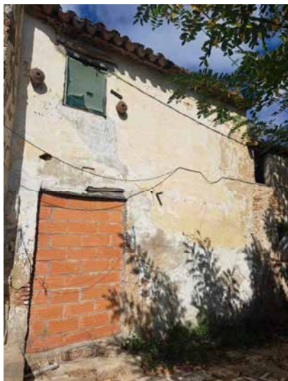
Façana principal del quart volum
