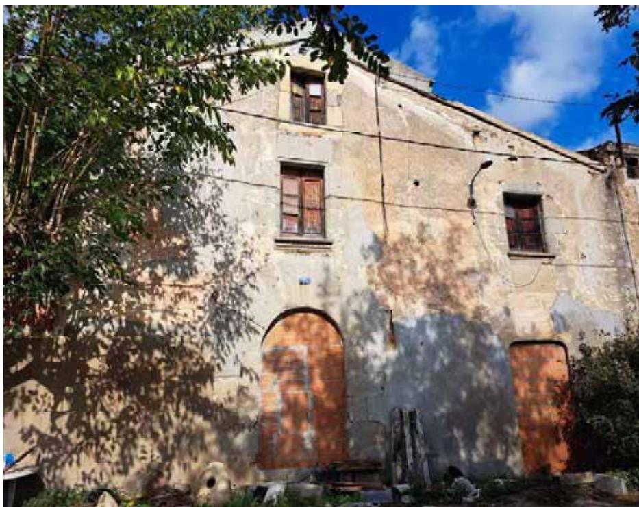
Façana de migdia del volum principal
