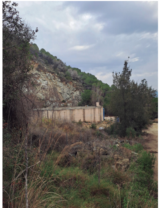
Dipòsit de la Pedrera de 2.000 m³ (març de 2024)
