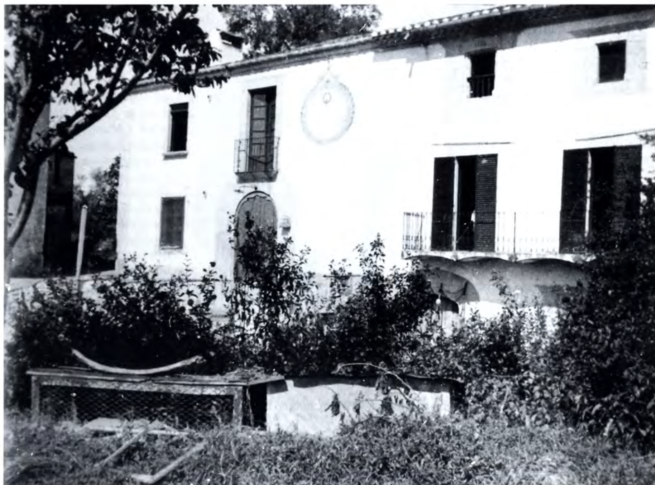
Una imatge antiga de la façana de Can Saborit amb balconades i el rellotge de sol.
