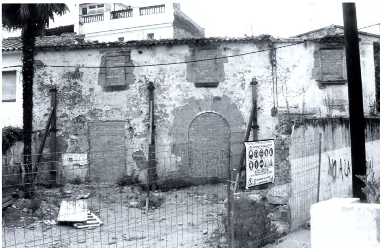
En aquest moment la masia de Can Ros de la Font està en obres.
