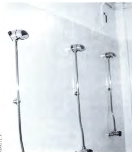
Nou gimnàs, noves dutxes.
