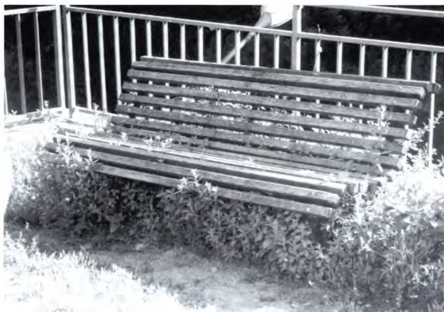
Una mostra del deteriorament d'alguns espais públics.
