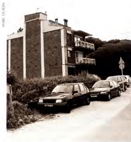
Vista de la casa afectada.
