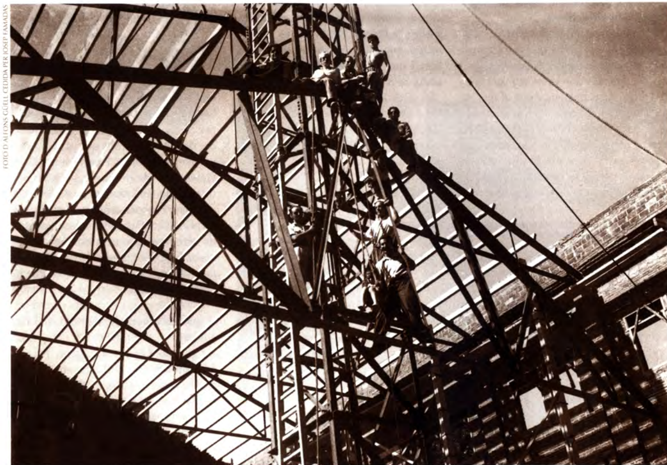
A mitjans dels anys 40 s'inicià la construcció del gran edifici. En la imatge, els operaris aixecant la teulada.
