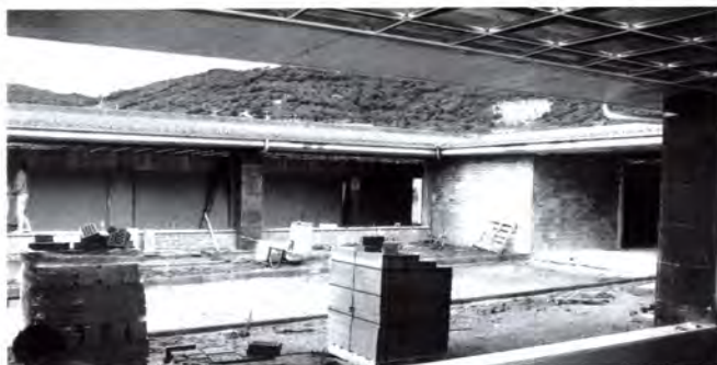
Les obres de la futura Àrea Bàsica de Salut d'Argentona
