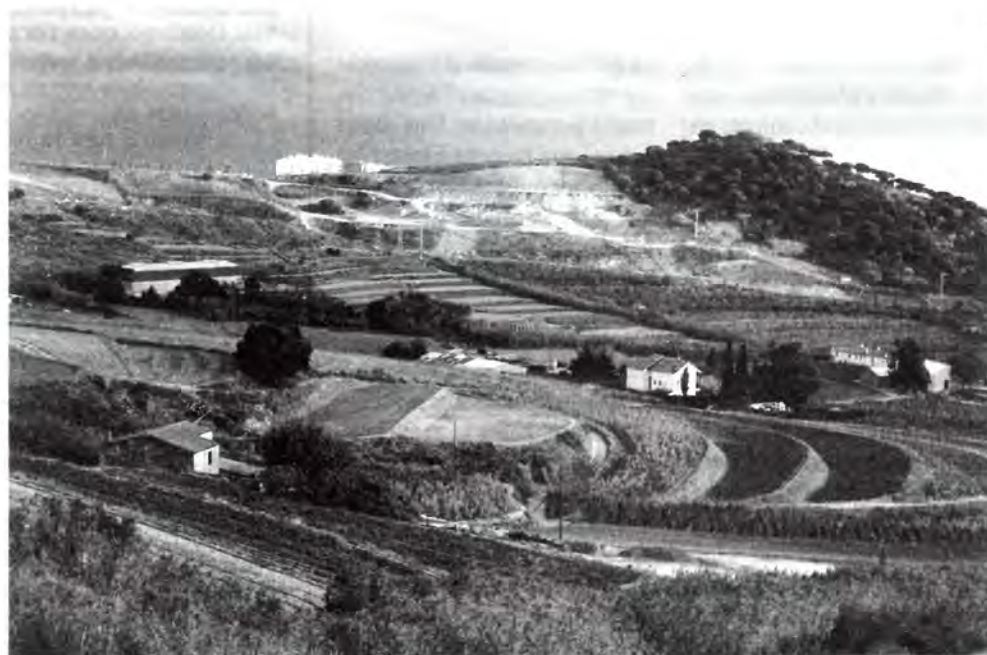
Vista general del Torrent de Vera, a l'esquerra la nau afectada.
