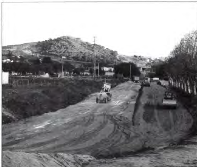
Estat de les obres de la carretera del Cros.
