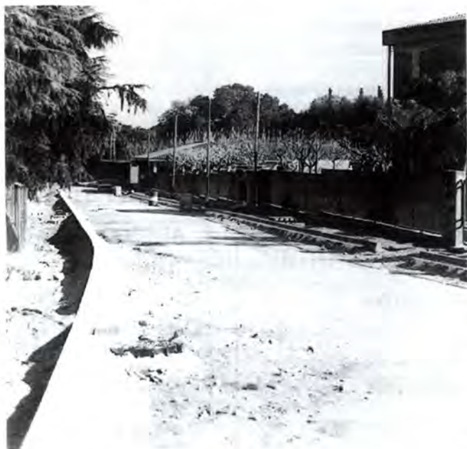
Les obres aturades.
