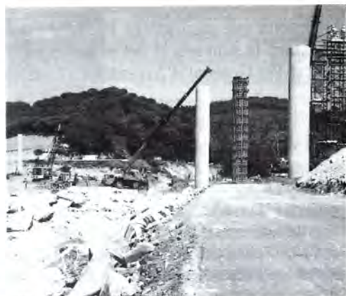
Aspecte de les obres de la B-40 al pas per Argentona.
