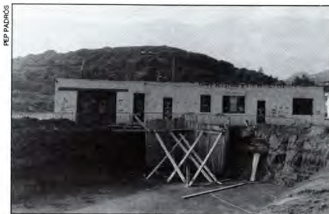
Les casetes afectades pel pas de la variant.
