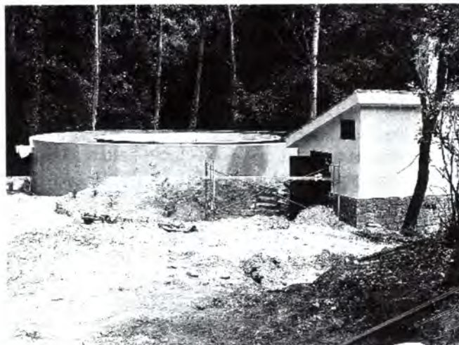
La depuradora en la fase final de construcció.
