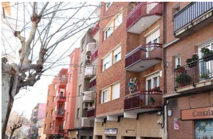
Els habitatges plurifamiliars es concentren al centre d'Argentona i al barri de Sant Miquel del Cros (MRM).
