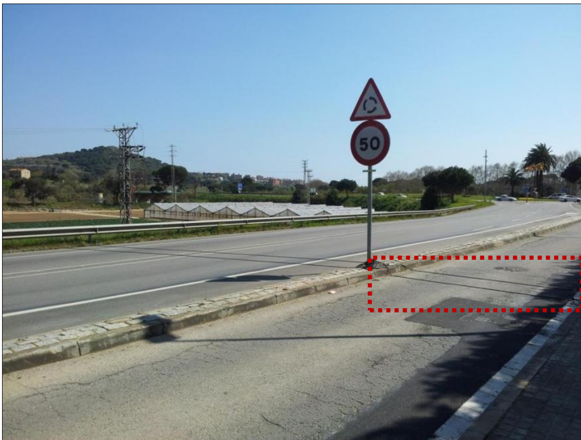
Figura 6 Ubicació de l'aforament al lateral de la Ronda Llevant. Font: CINESI
