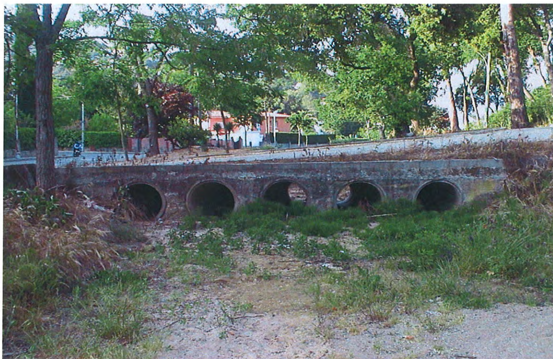
Fotografia 1 .- Estat actual del gual a diferent nivell del carrer 6 (5 canonades de 60 cm)
