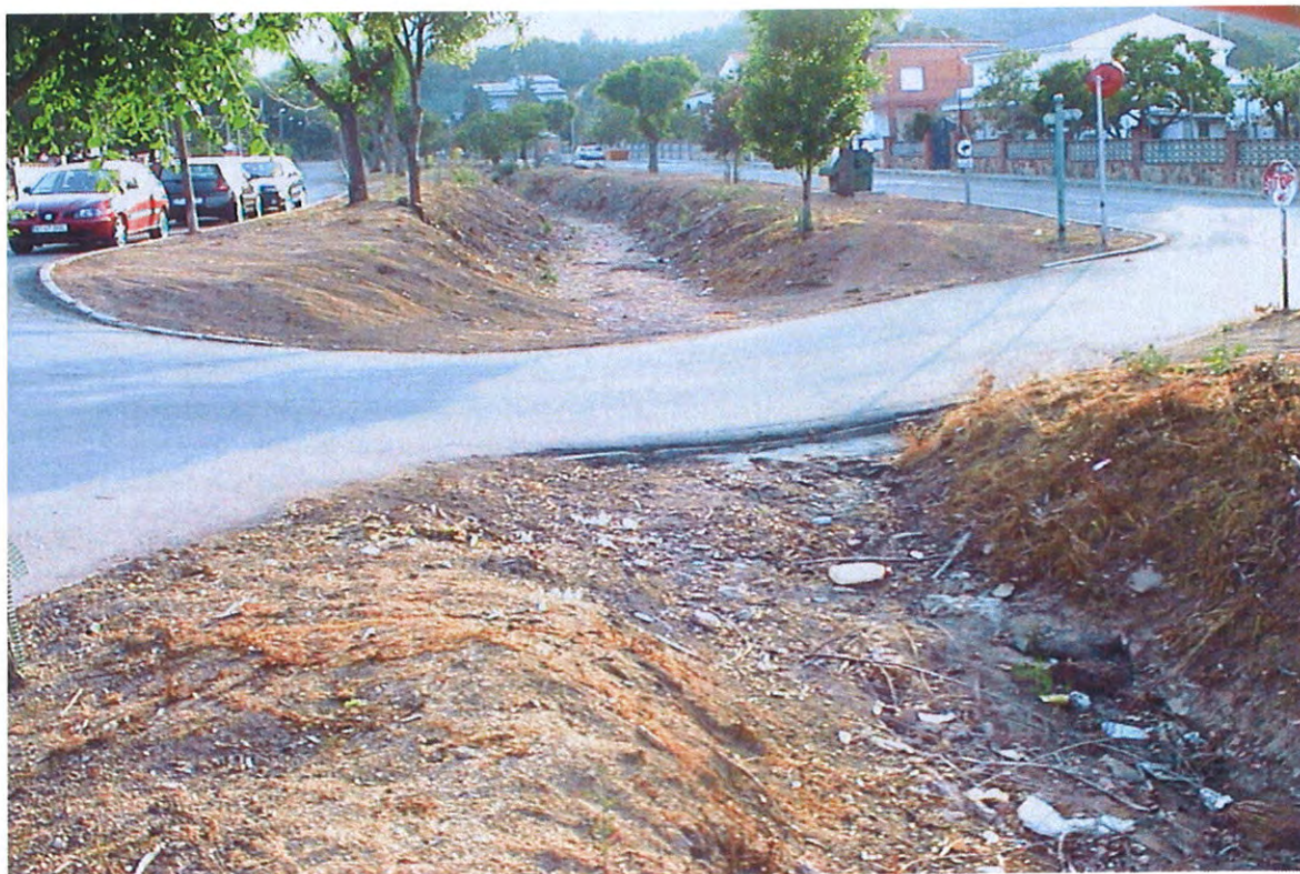
Fotografia 3 .- Estat actual del gual a nivell del carrer 11 vist desde aigües avall
