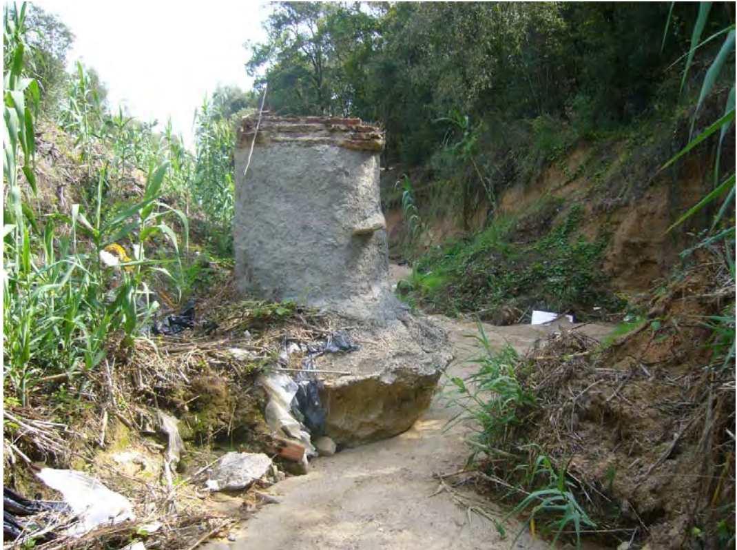
Fotografia 6.- Erosió del fons de la llera i efectes sobre l'estabilitat dels marges
