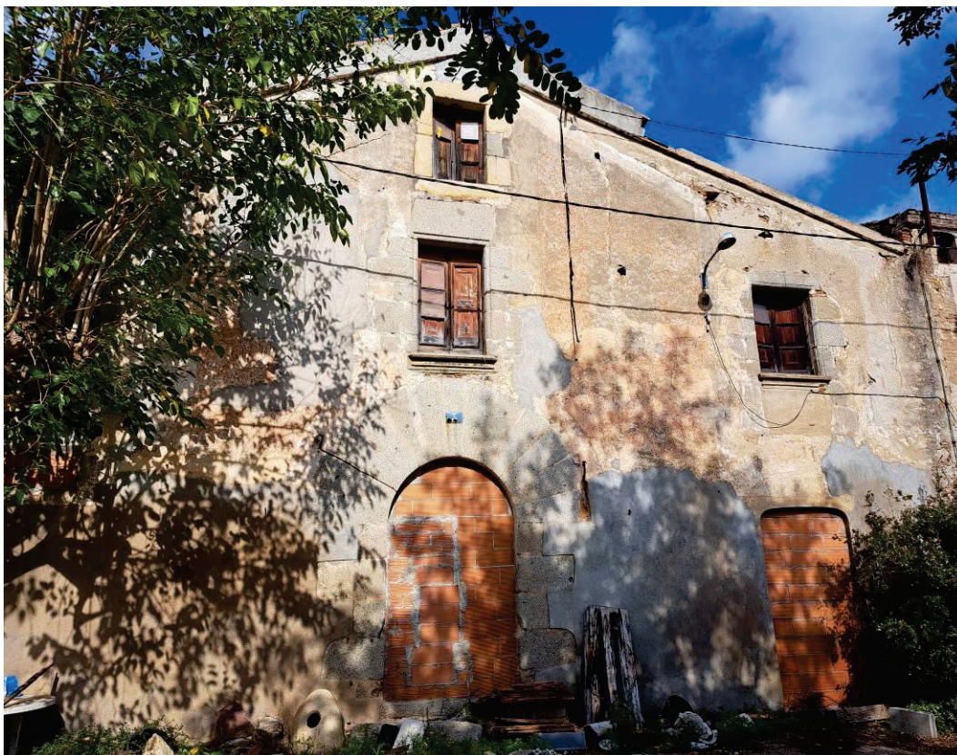
Façana de migdia del volum principal
