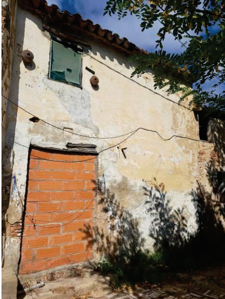
Façana principal del quart volum
