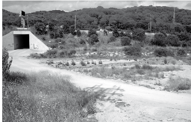
Punt de la riera d'Argentona per on passa la canonada que connectarà amb el col·lector.
