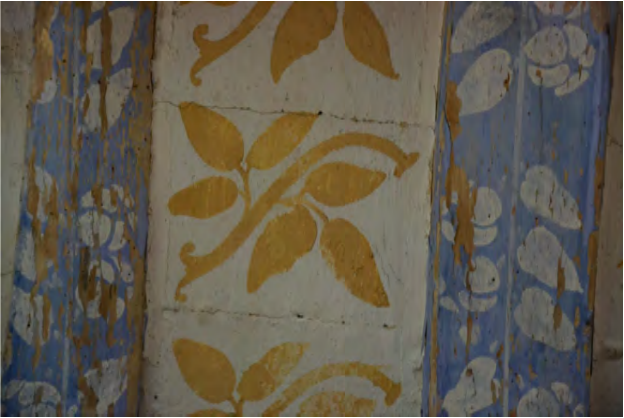
Imatge 10. Imatge interior sostre detall 2
