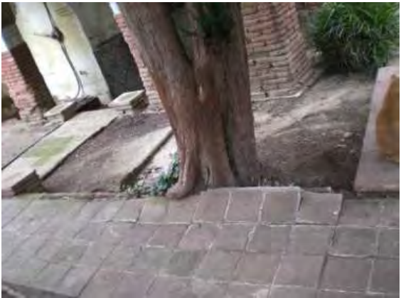
Imatge 3 Teix situat a l'angle del porxo. Desplaçament de les toves per el creixement del teix
