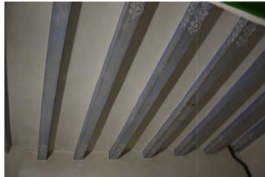
Imatge 5. Sostre habitació
