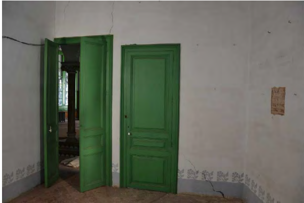
Imatge 5. HABITACIÓ D'EN PUIG I CADAFAALCH. Pl. primera Esquerda per excés de deformació (fletxa)
