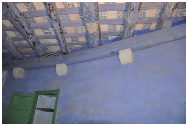
Biga perimetral de reforç en Planta Baixa
