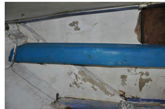
Biga metàl·lica folrada amb tronc de fusta. Planta segona
