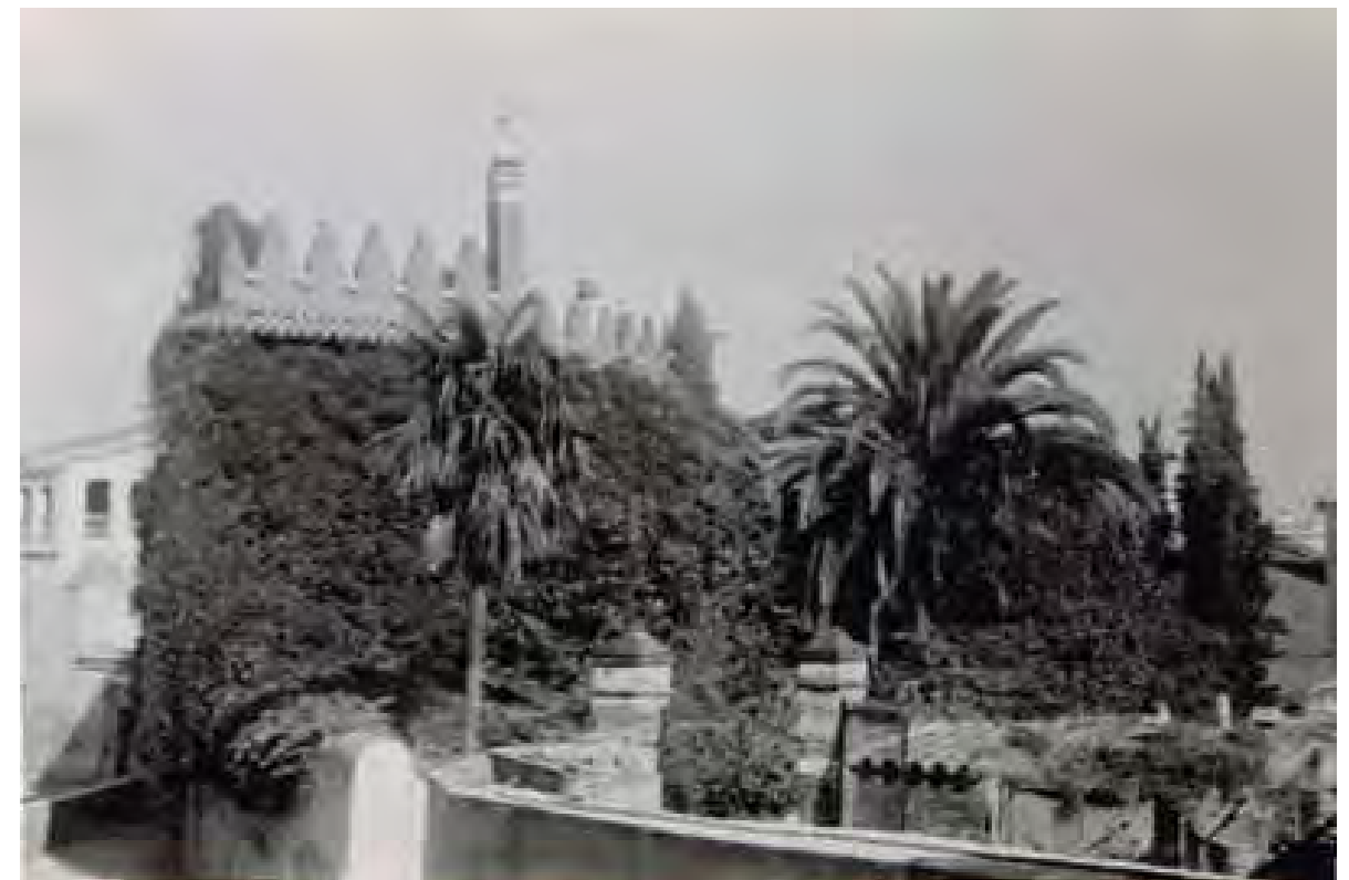
Imatge 10 Fotografia històrica: palmera excelsa a esquerra de la imatge i palmera de Canàries a la dreta de la imatge.
