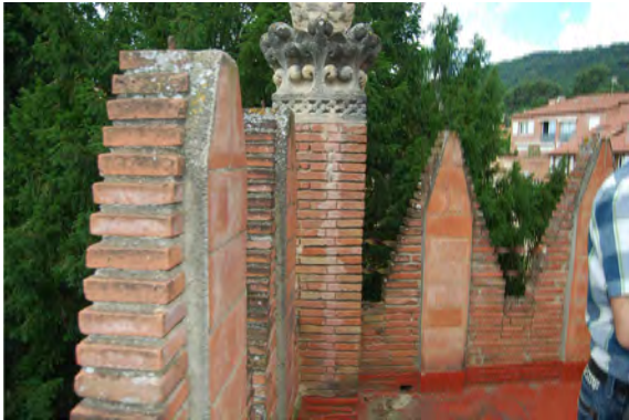
Imatge 13. EXTERIOR-TERRASSA. Planta segona Engaltat realitzat per en Puig i Cadafalch per compensar l'esveltesa dels marlets.
