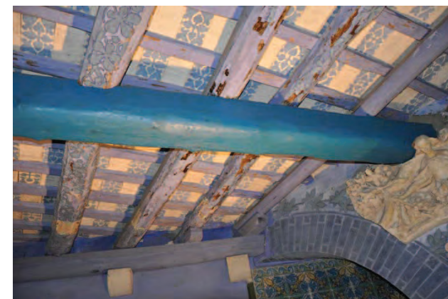
Partillum de biga metàl·lica folrada amb tronc de fusta. Planta baixa
