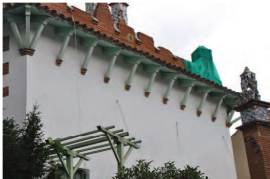
Peces de tornapunta en façana
