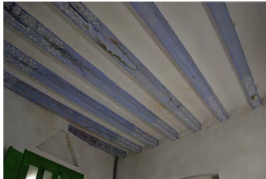
Imatge 4. Sostre habitació
