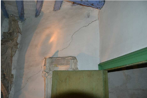
Imatge 5. DISTRIBUIDOR PRÈVI DESPATX. Planta baixa. Esquerda que marca la presència de l'escala
