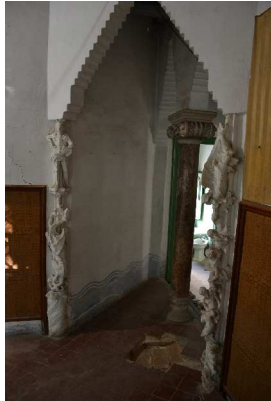
Imatge 7. DISTRIBUIDOR. Pl. primera Esquerda per excés de fletxa
