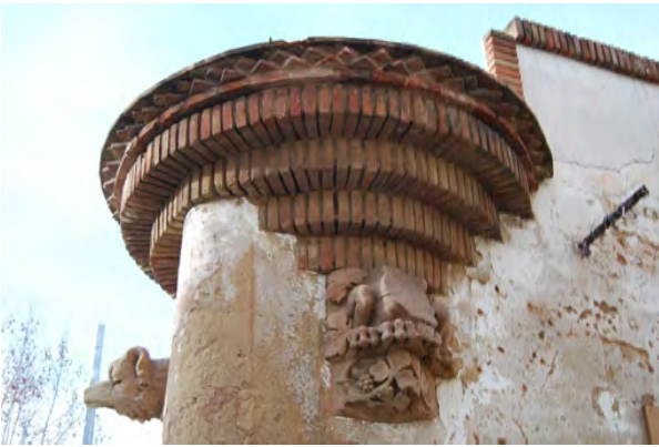
Imatge 3. CELLER. Planta baixa Pèrdua de propietats portants de l'estructura per un excés d'humitat. En fases anterior es col·loquen elements que disminueixen les distàncies entre suports, degut a llums excessives.
