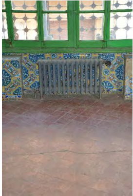
Imatge 6. SALA. Pl. primera Esquerda per excés de fletxa
