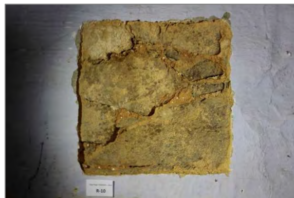
Cala R-10. Mur de paredat de pedra
