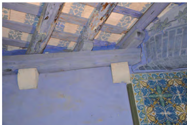
Biga perimetral de reforç en Planta Baixa
