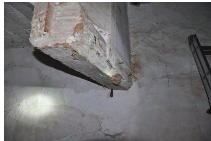
Biga encastada que sustenta l'arrencament de l'escala
