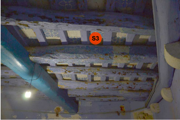
Imatge 7. Imatge interior del sostre
