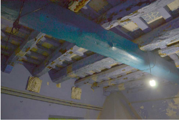
Imatge 8. Imatge interior del sostre
