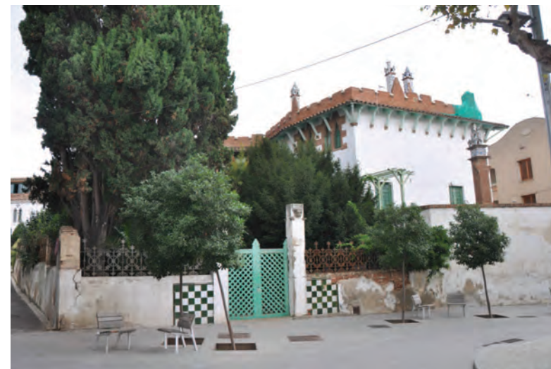
Aspecte de la façana de l'edifici
