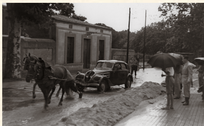
• Acumulació de fang i sorra als laterals de l'actual Avinguda Puig i Cadafalch, provocada per la carència de clavegueram. En segon terme, edifici del gas
