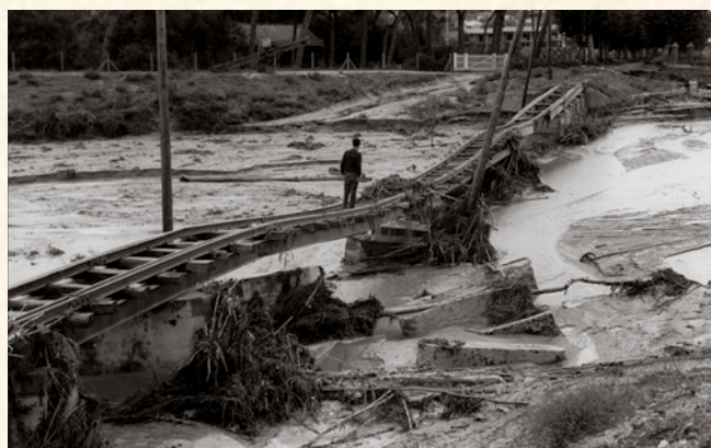
• Pont del tramvia arrasat per l'aiguat de la tardor de 1965. La destrucció de la via va provocar la clausura definitiva d'aquest mitjà de transport a Mataró
