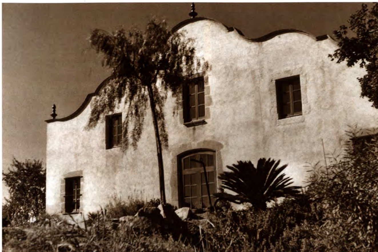
Una de les principals característiques d'aquesta masia és la façana amb corbes.
