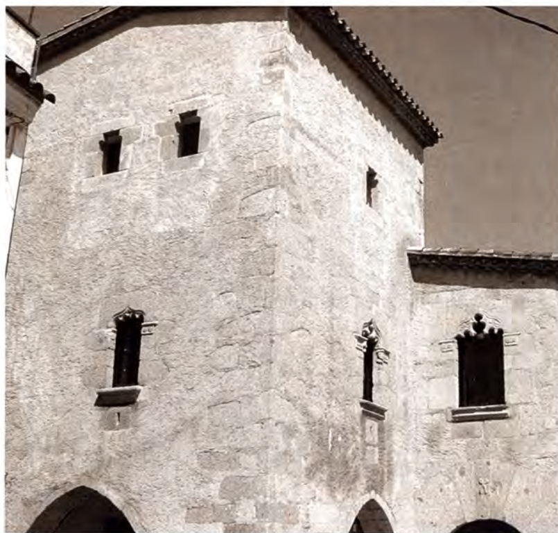
Aspecte actual de la Casa Gòtica.
