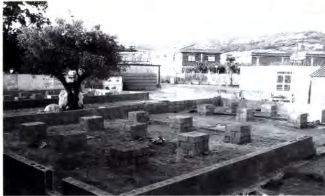
Zona de l'Institut en obres
