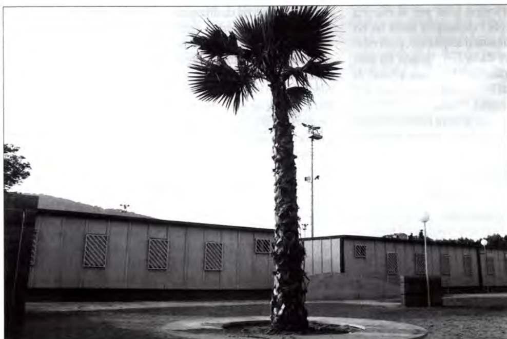
Vista general dels mòduls provisionals.
