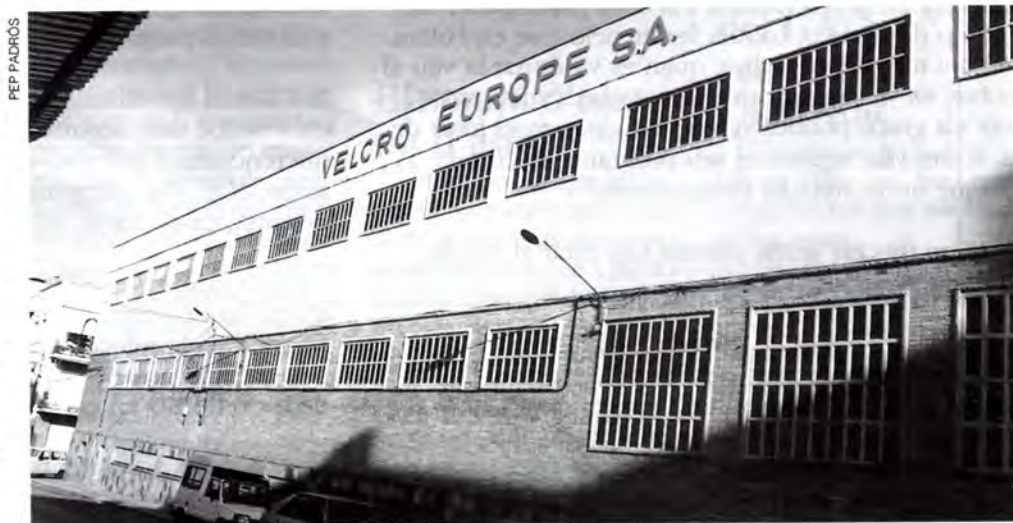
Façana de les antigues instal·lacions de la Velcro.
