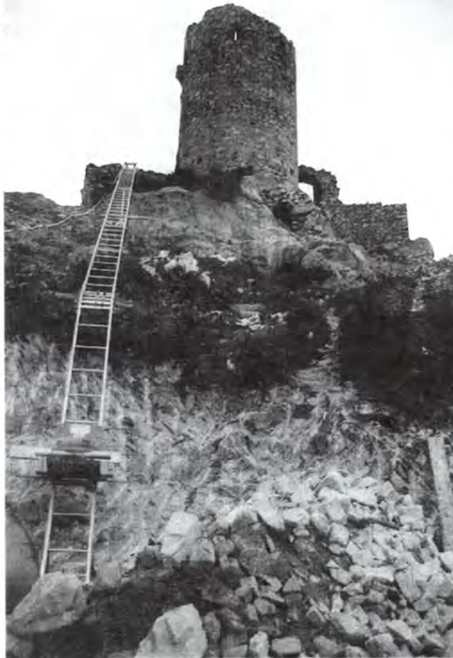
El castell i les obres de consolidació.
