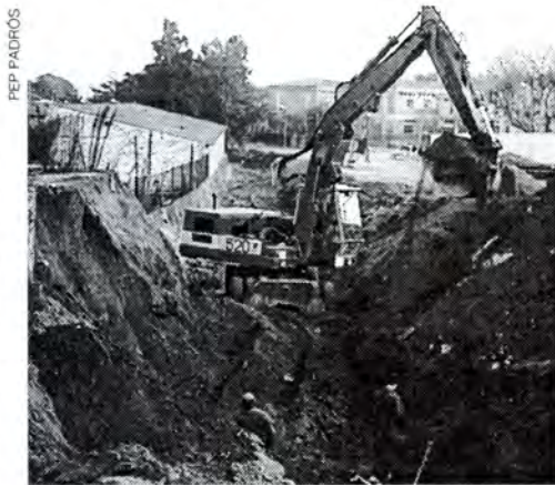
Les obres de la canalització del Torrent de Tossa.
