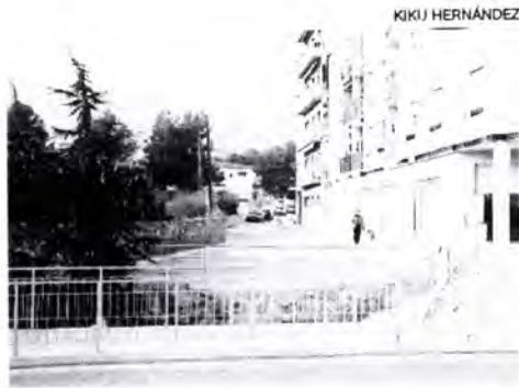
Les obres de pavimentació del torrent de Tossa.
