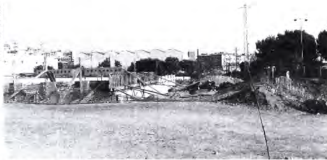
Túnel sota l'autopista al Cros.
