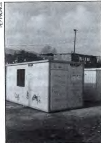
Casetes "provisionals" instal·lades per ACESA.
