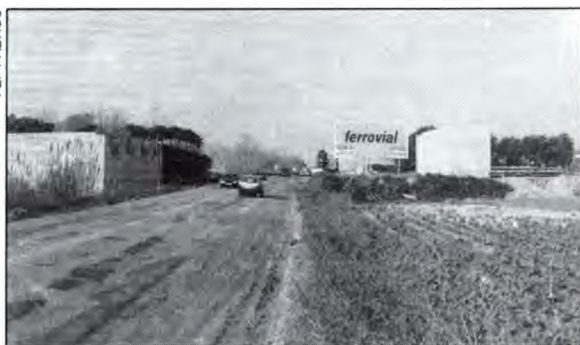
Aquí a l'alçada del Torrent de Vera hi haurà l'enllaç entre la variant de la N-2 i l'autovia.
