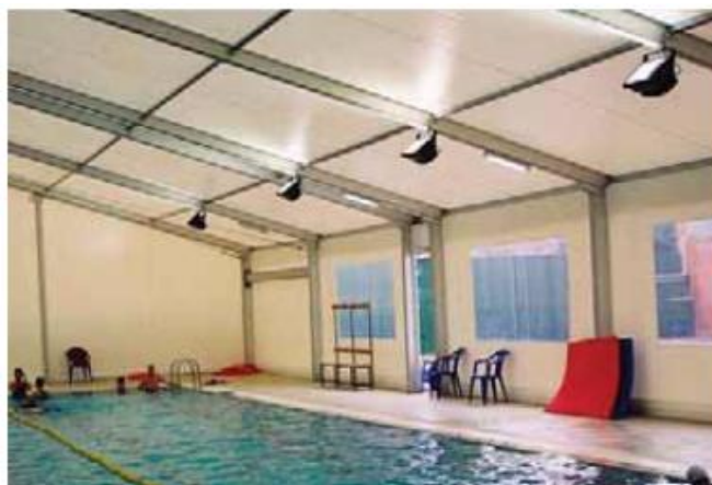
Imatge 14: Ubicació punts de llum indirectes. Exemple Piscina Municipal Sant Cugat (Barcelona)
